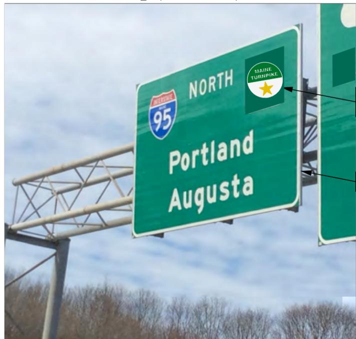
INSTALL NEW SHEET ALUMINUM OVERLAY OL-7 ON EXISTING SIGN
